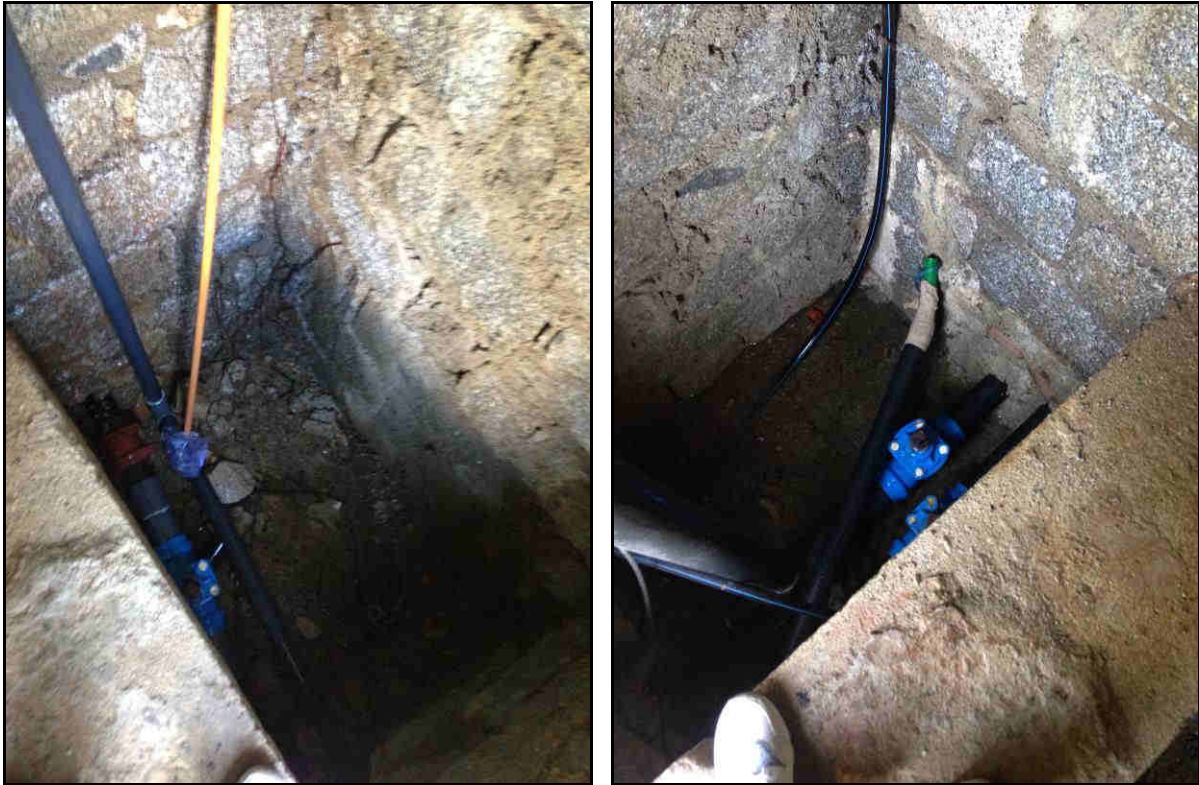
Intérieur de la chambre des vannes
